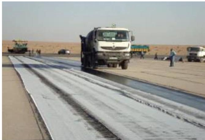
Figure 3. Mise en place de la géogrille sur la piste.
