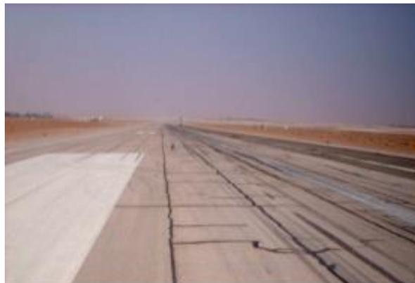
Figure 2. Fissures de joints sens longitudinal et transversal.
